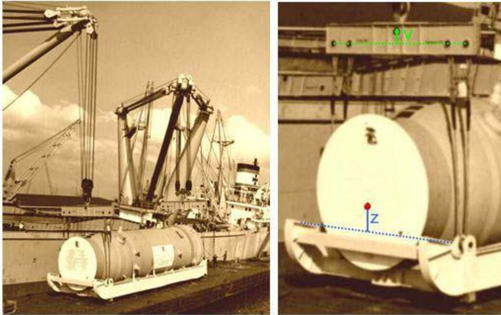
Bild 1.5: Heben eines Kernreaktors, Naheinstellung von Schwerpunkt und Aufhängezentrum
