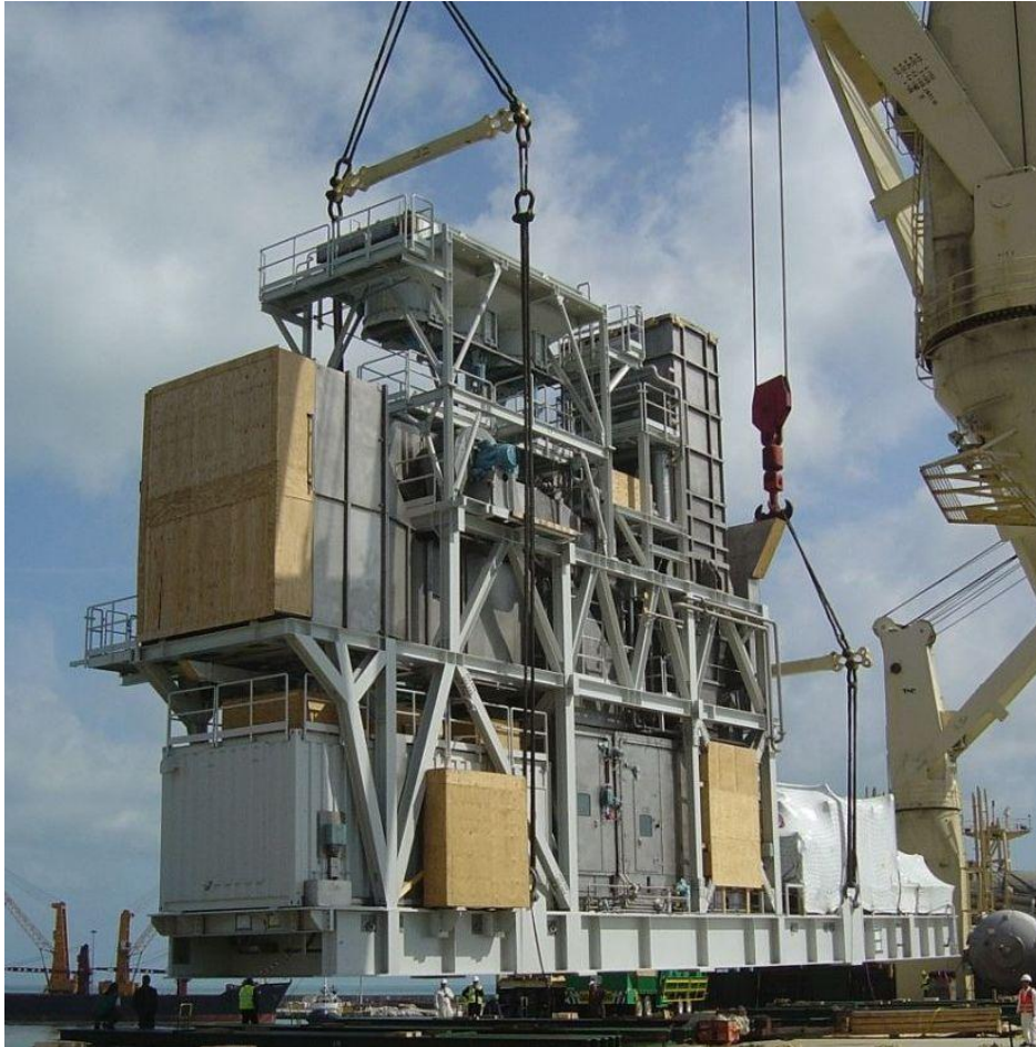
Bild 1.12: Tandem-Umschlag mit asymmetrischer Aufhängung
