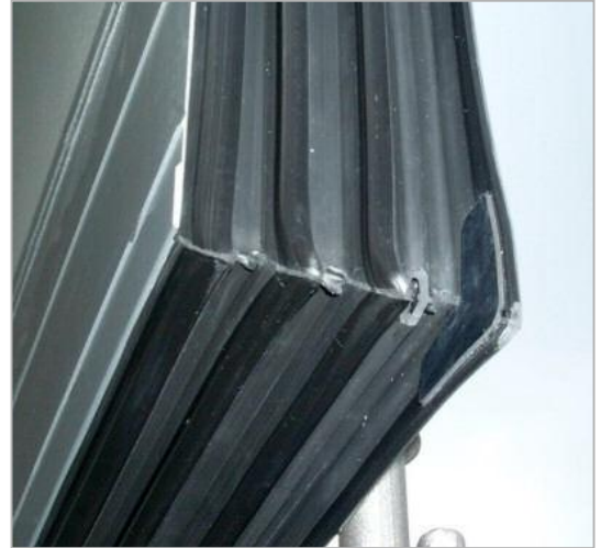
• Dichtung der RWT
