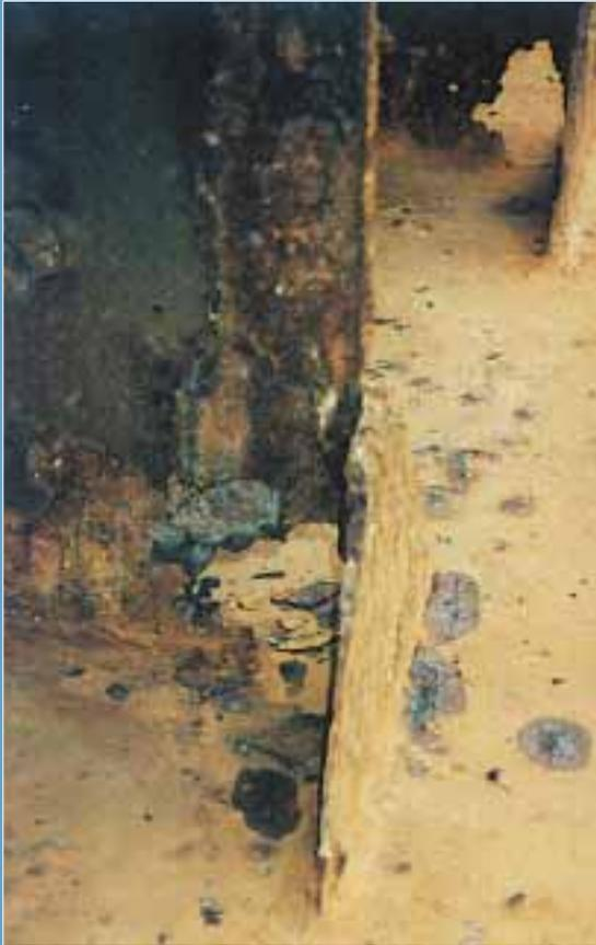
Starke Korrosion im Deckslukenbereich - Material ist teilweise nicht mehr vorhanden - die Betriebsfestigkeit des Bauteiles ist in diesem Bereich nicht mehr gewährleistet.
