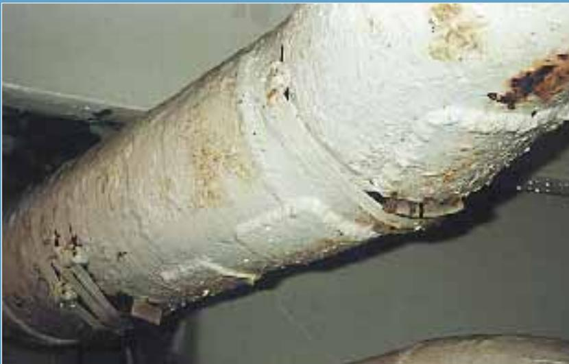
Häufig findet man z.B. bei einem »on hire survey« notdürftig reparierte oder besser gesagt »geflickte« Leitungen. Holzkeile werden in Leckagen geschlagen und mit Stahlmanschetten (die eigentlich für die Verpackungsindustrie gedacht sind) eingepreßt. Gummistücke, die auf gleiche Weise eingepreßt werden, leisten ähnlich »gute Dienste«. Sind die Leckagen zu groß, behilft man sich mit »Stahlblechflicken«. So erinnert manche Pipeline eher an einen Flickenteppich als an ein sensibles Schiffbauteil.
