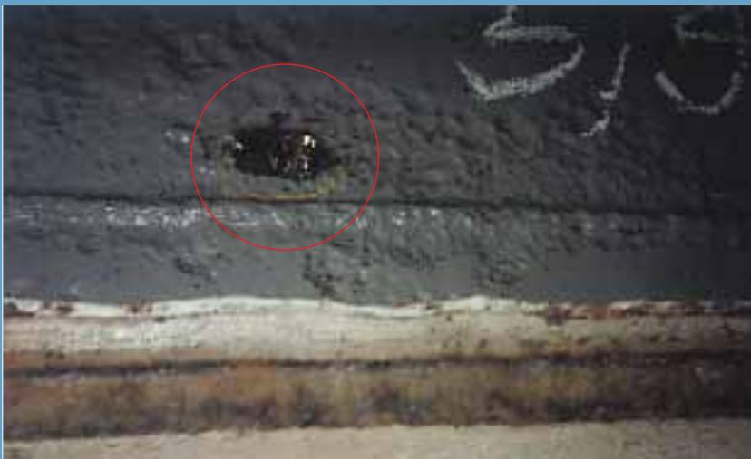
Der markierte Bereich zeigt eine ausgeschliffene Stelle zur Dickenmessung mit einer Restdicke von 5,9 mm. Die punktförmigen Anfrassungen lassen die Tropfenstruktur der schwefeligen Säure erkennen.
